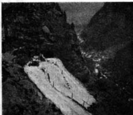
Tourniquets della vecchia strada dopo la Galleria
